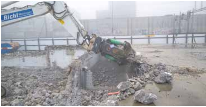
Der Egli-Betonbeisser XMB 3.7 mit Bionic-Gebiss. Dieser kann Betonstärken bis etwa 50 Zentimeter Durchmesser in einem Arbeitsgang brechen, pulverisieren und die Bewehrung kurzschneiden. Martin Sekinger von der Firma Richi AG freut sich nach dem geglückten Rückbau an der Vulkanstrasse in Zürich.
